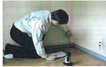
総合診断 レーザー測定器で床や柱の傾斜をみたり、雨漏りの有無など、全体を診断します。
