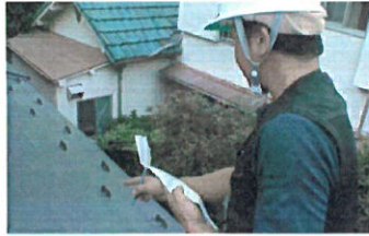
屋根診断 老朽化による割れや傷み、サビなどを隅々までチェックします。
