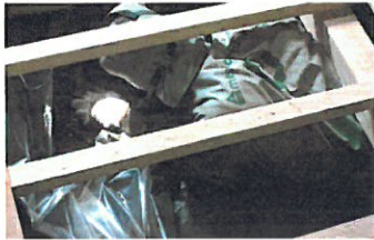
床下診断 床下から、基礎や土台の状況やシロアリ被害の有無などを確認、診断します。
