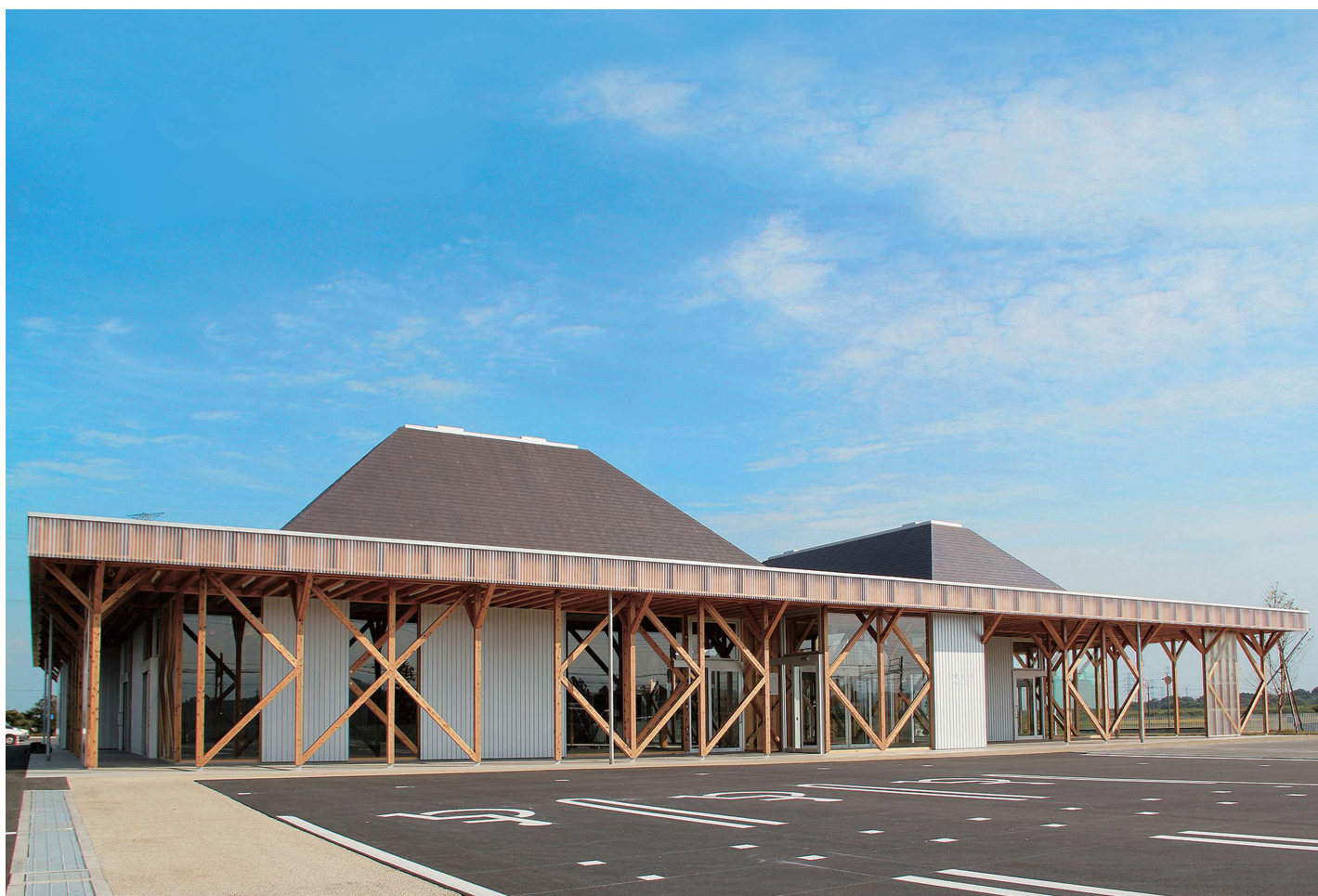
新築移転した東松山農産物直売所（愛称：いなほてらす）
